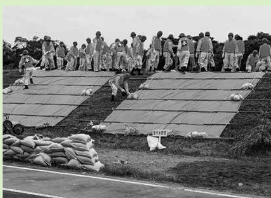
シート張り工を行う無動寺水防団・田代水防団
