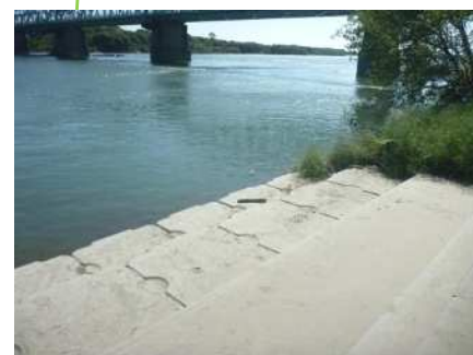
④史跡終点の湊跡の根固めブロック
