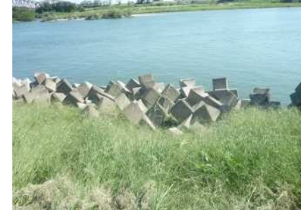
①河岸侵食防止用根固めブロック
