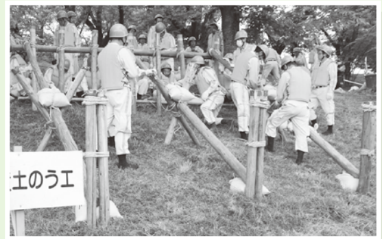
杭打積土のう工を行う円城寺水防団
