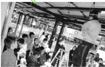
高校生とインリーダー生による設置作業の様子
