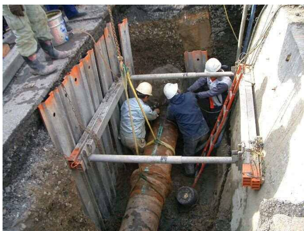
写真 3-2-1-1 伸縮可とう管設置前 (配水本管の耐震化工事)
