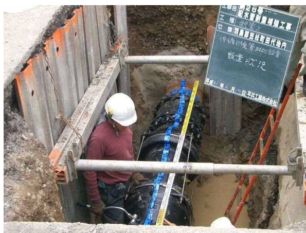
写真 3-2-1-2 伸縮可とう管設置後 (配水本管の耐震化工事)
