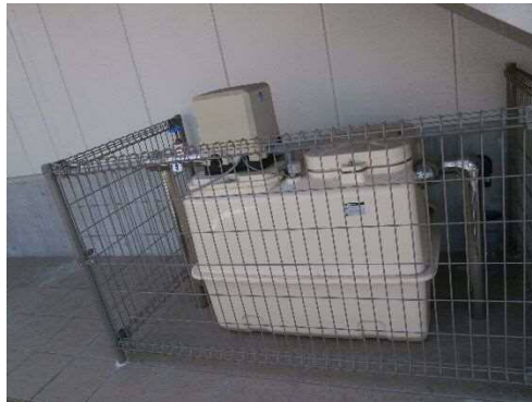
写真 1-3 集合住宅の貯水槽（参考）
