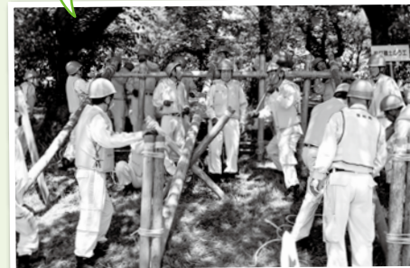
杭打積土の工を行う無動寺水防団員
