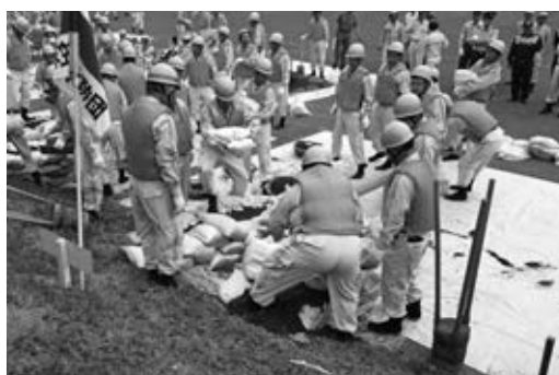
月の輪工法を行う水防団員
