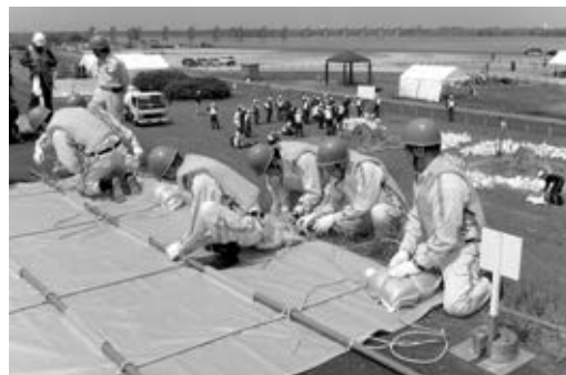
シート張り工を行う水防団員
