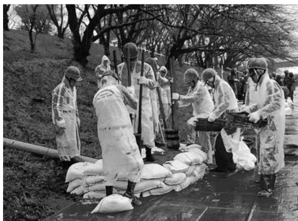
半月状に土のうを積み、砂を詰め踏み固める（月の輪工法）水防団員
