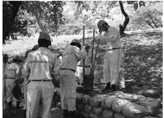
土のうの継ぎ目に土砂を詰め、踏み固める（積土のう工）水防団員
