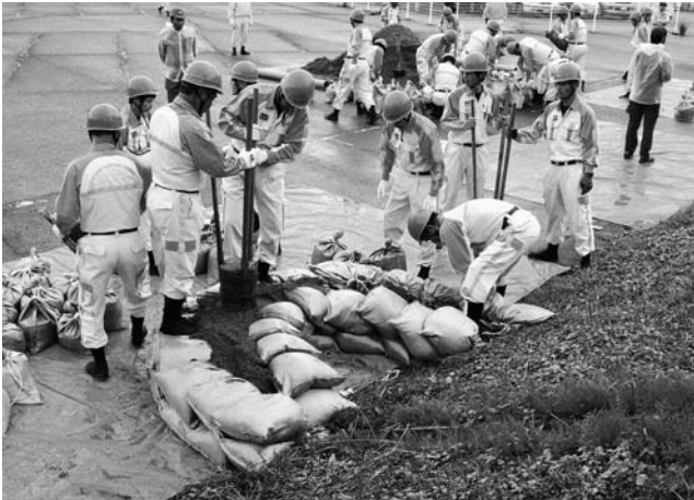
半月状に土のうを積み、つぎ目に砂を詰め踏み固める(月の輪工法)水防団員
