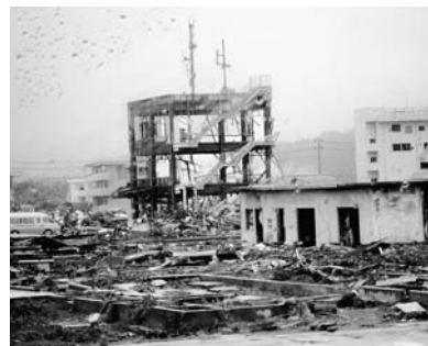
訪問した当時の南三陸町防災センター
