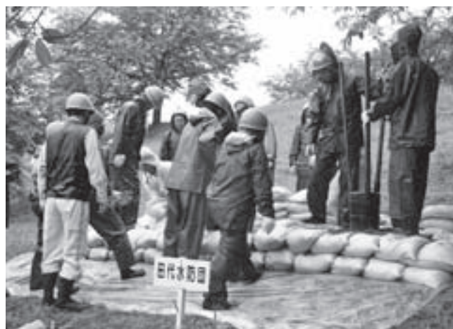
積土の工をする田代水防団員
