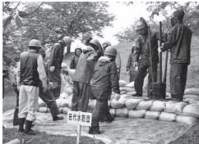
積土の工をする田代水防団員
