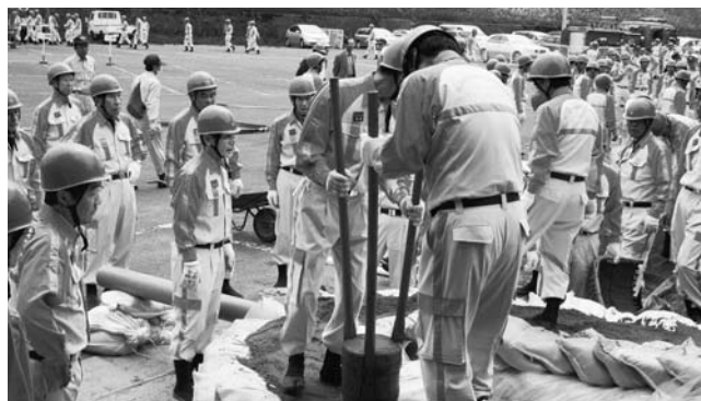
土のうを半月状に積み上げ月の輪工する無動寺水防団員
