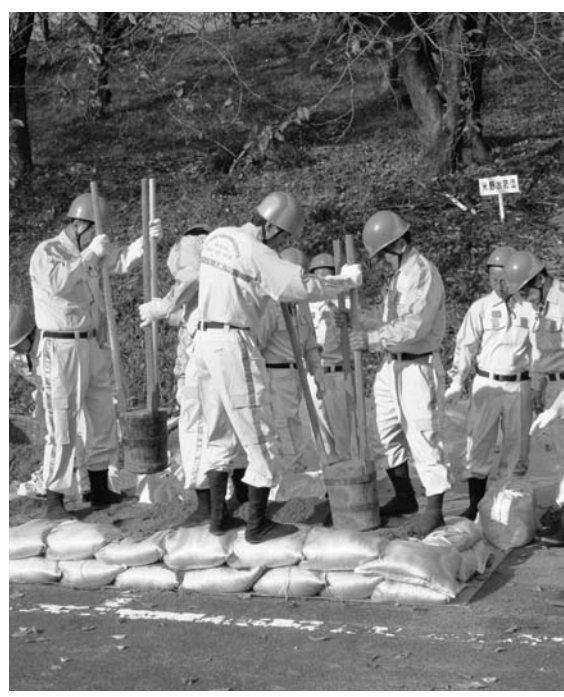
積土のうを突き固める米野水防団
