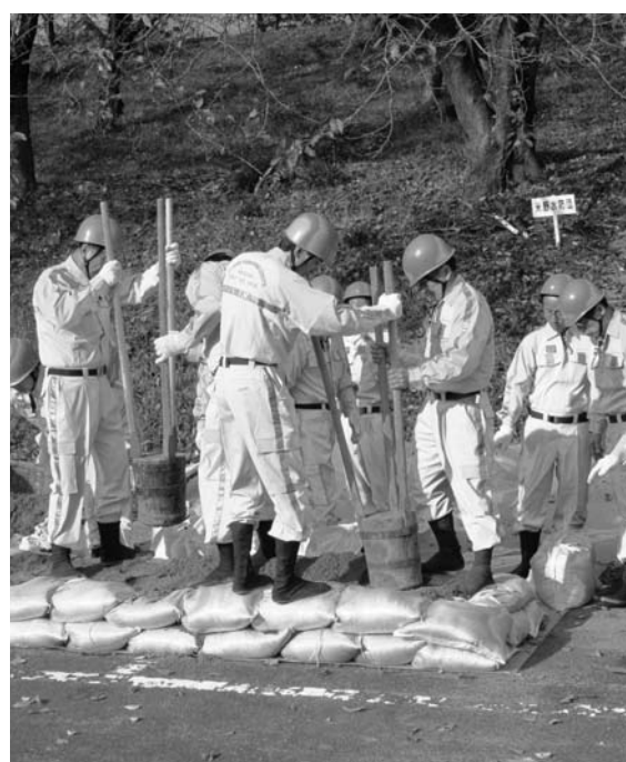
積土のうを突き固める米野水防団
