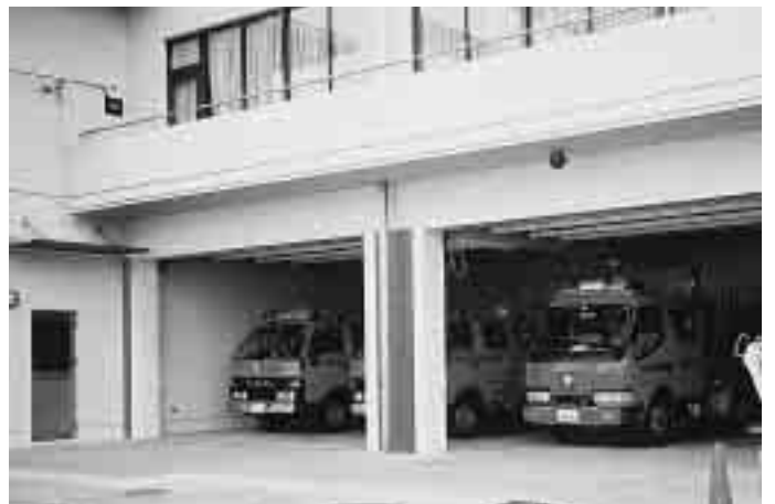
完成した第3分団消防車庫
