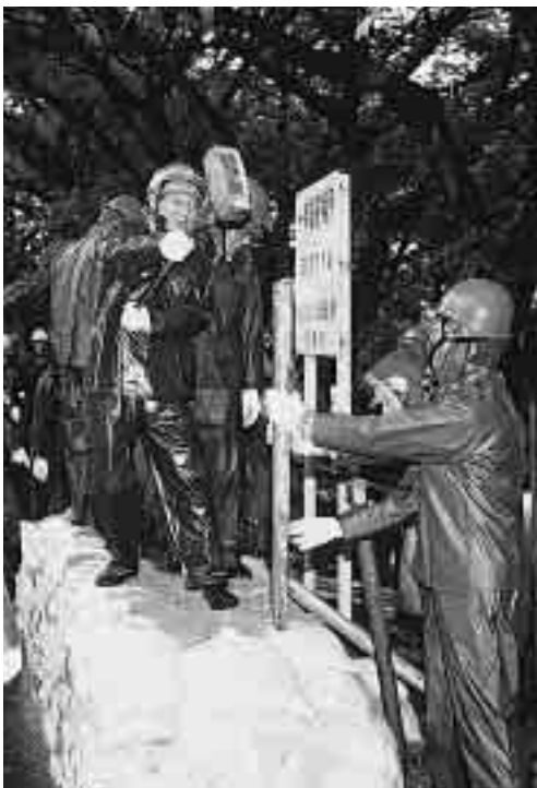
降りしきる雨のなか、本番さながらにキビキビとした動作で「積土のう工」を行う団員たち
