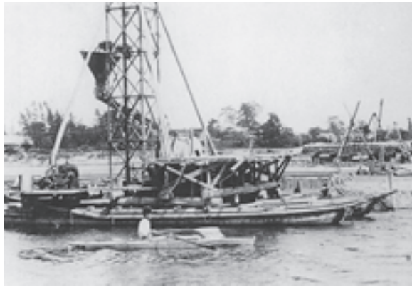
昭和十年当時の木曾川橋脚建設工事の様子
