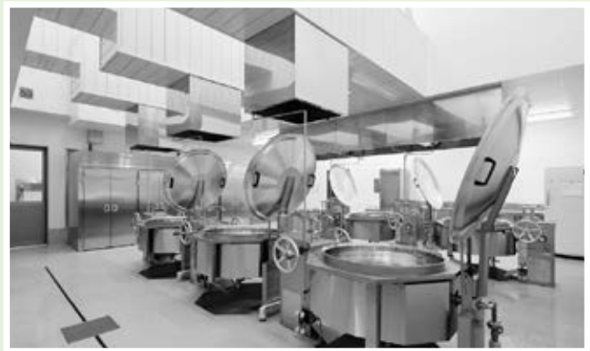
新しい設備が整う調理場内
