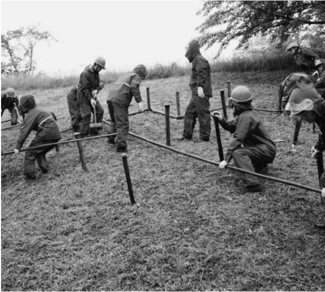
杭木に青竹を継ぎ止める(籠止め工)笠松水防団員
