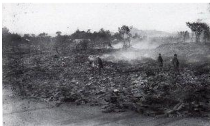
地震後の火災で、一面焼き尽くされました
