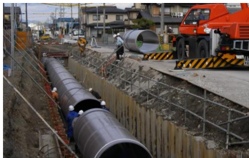
パイプライン化された羽島用水 (工事中の時の写真)
