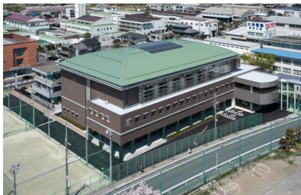
平成26年に完成した笠松中学校屋内運動場
