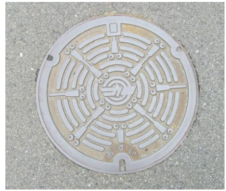
トンボが見守るマンホール蓋
