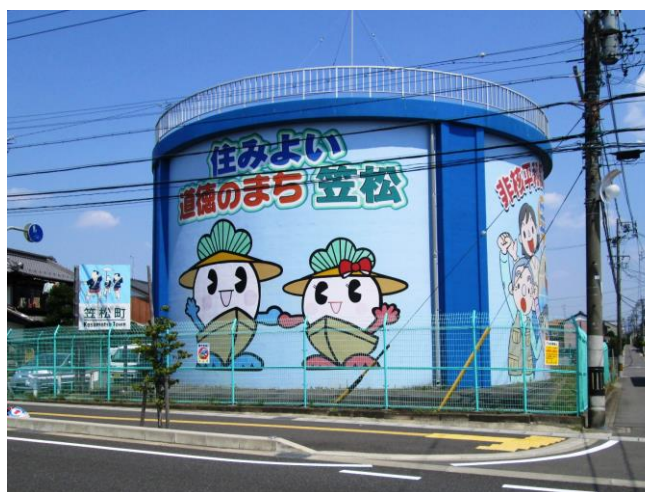
主要地方道(美笠通)沿いにある第一水源地
